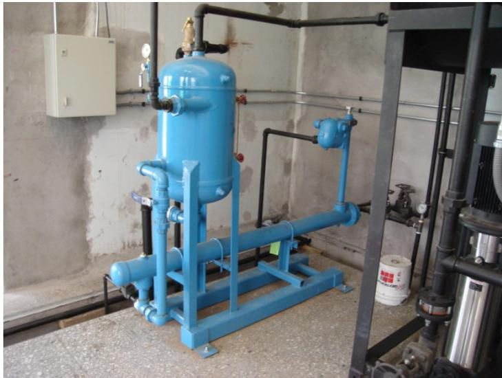
**Figura 3: Ejemplo de estanque de purga integrado, gentileza de Wilson Engineering.**
