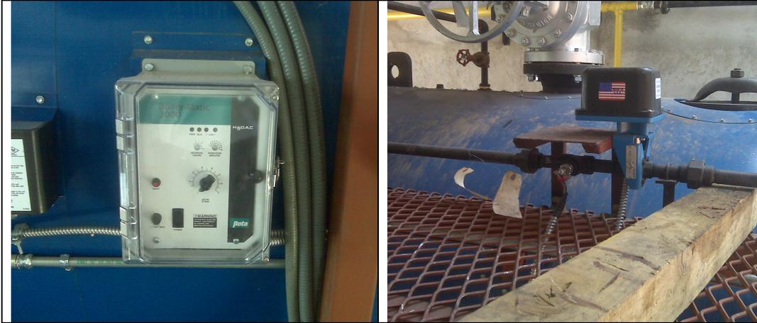
Figura N°3: Sistema de purga automático de superficie.
