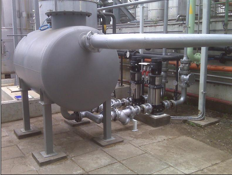
Figura N°4: Estanque recolector de condensado y sistema de bombeo.
