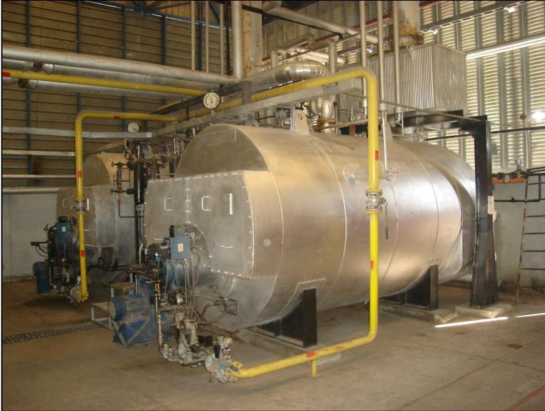
Figura N°1: Economizadores instalados en calderas.
