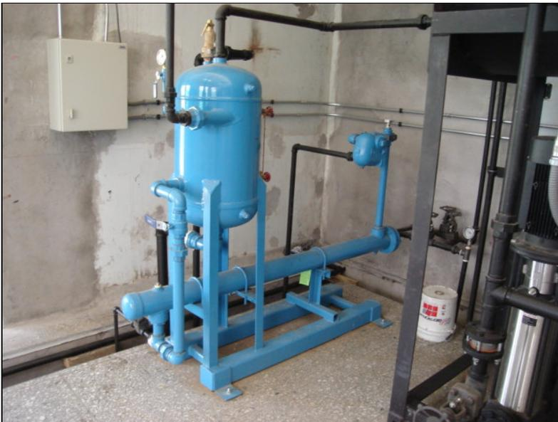
Figura N°2: Recuperador de calor purgas instalado en caldera.
